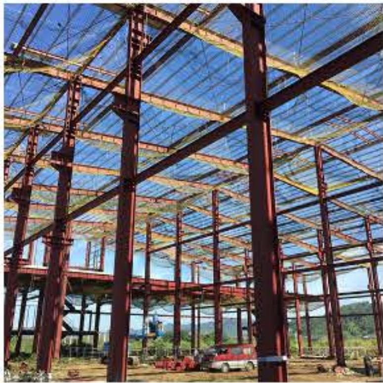
南投天承鍛鋼構工程
