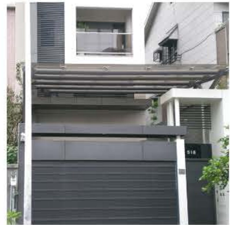
徐宅結構雨遮工程
