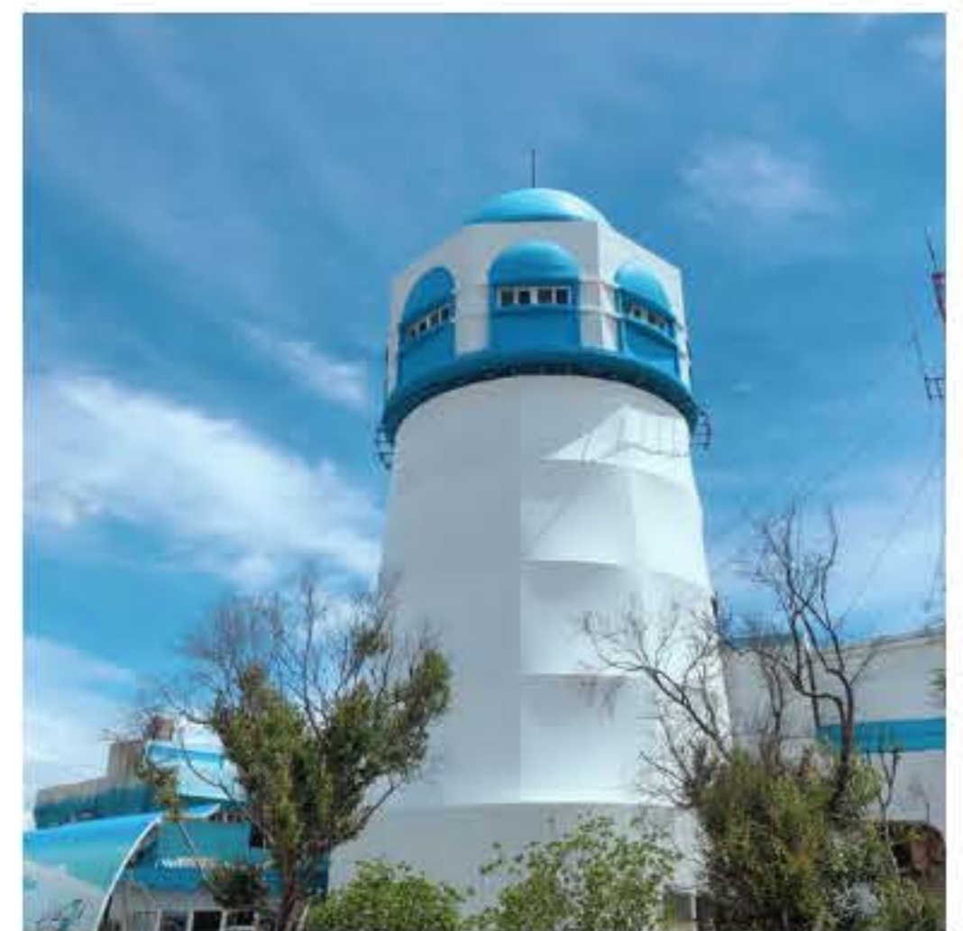
梧棲漁港魚貨直銷中心膜構工程
