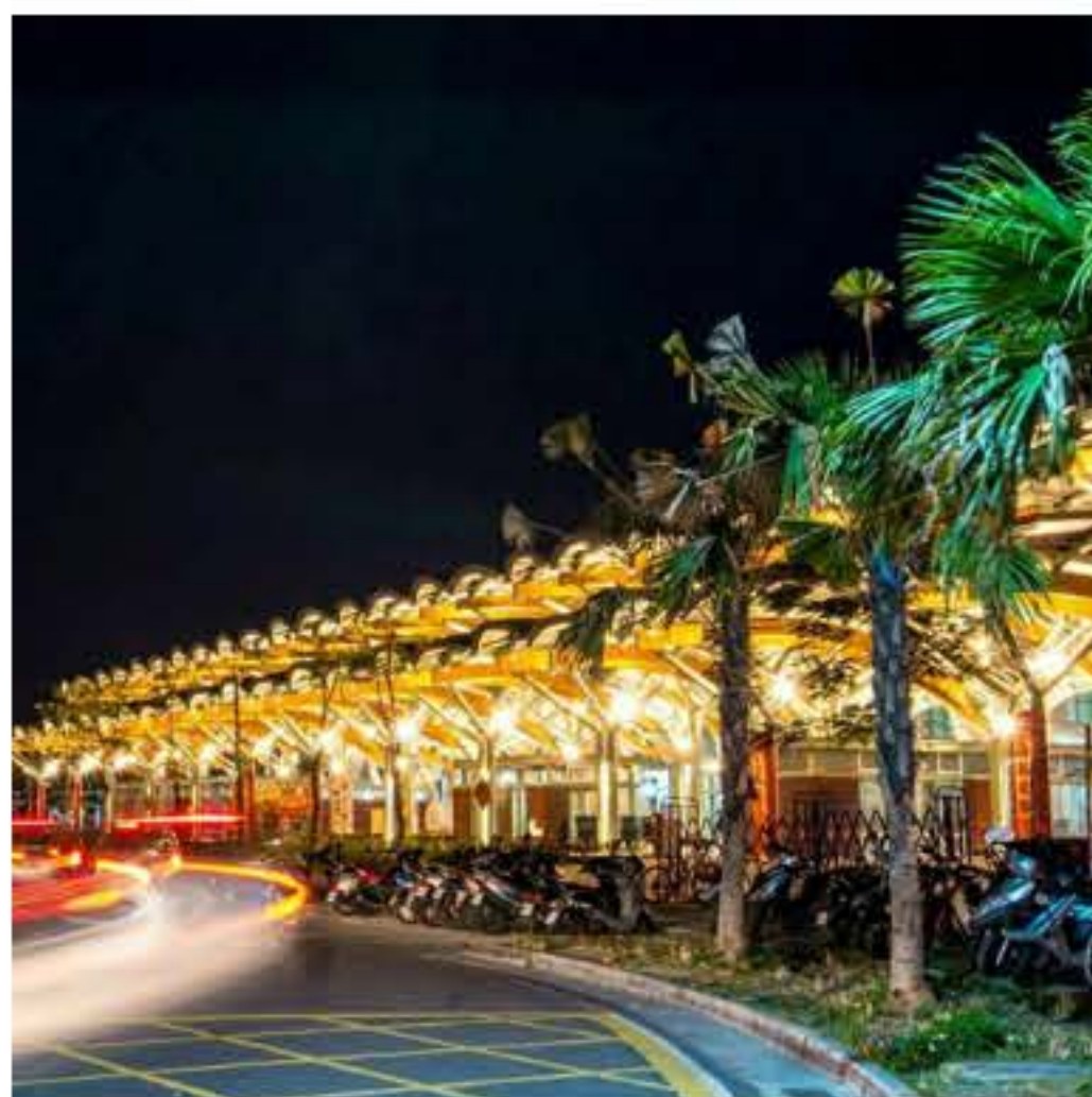
SL305-4 標台車站新建工程夜晚攝影
