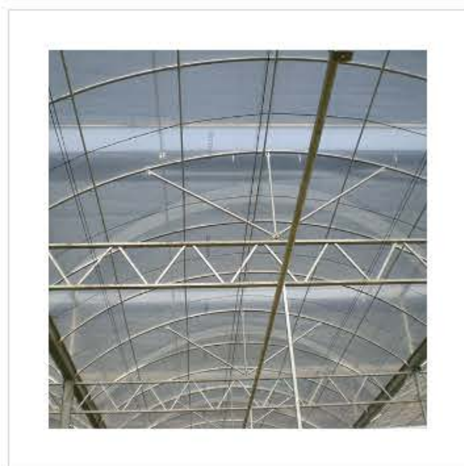
台南蘭花科技園區工程
