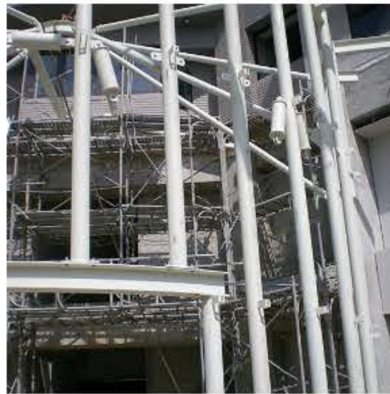
八里商港段集合住宅玻璃帷幕鋼構工程
