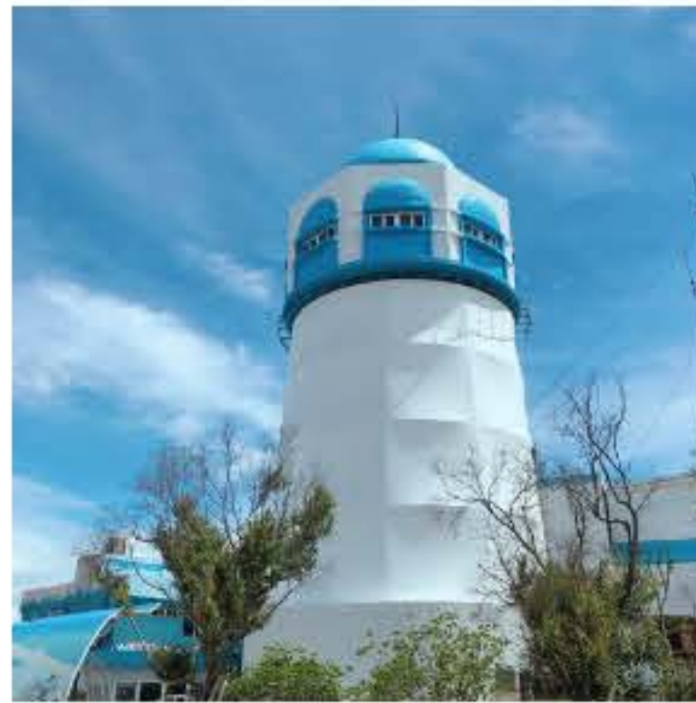
梧棲漁港魚貨直銷中心膜構工程
