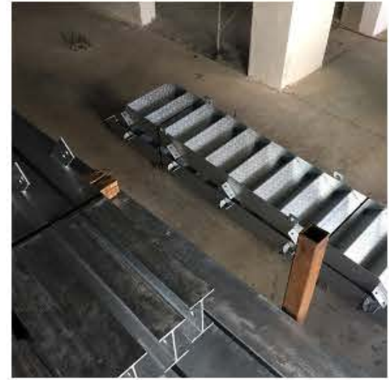
中華立鼎光電中壢工業區鋼構工程
