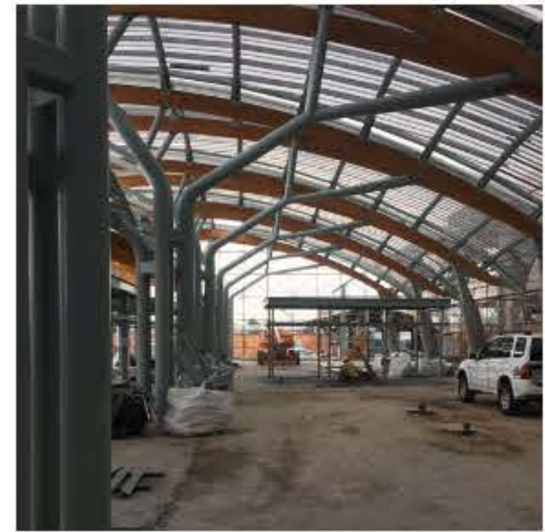
SL305-4 標台東站新建工程
