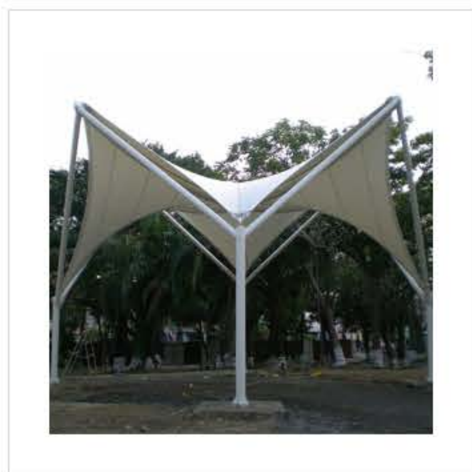
高雄岡山仔公園工程
