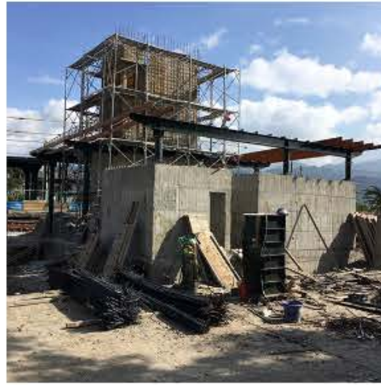
SL305-4 標瑞源站新建工程 - 廁所鋼構
